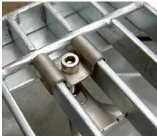
安裝夾固定 Installing fixing clips
